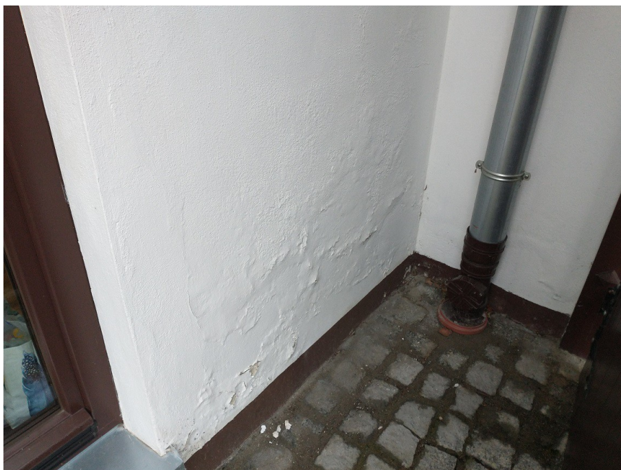
fot. 4. Uszkodzenia tynku i powłoki malarskiej na elewacji.
